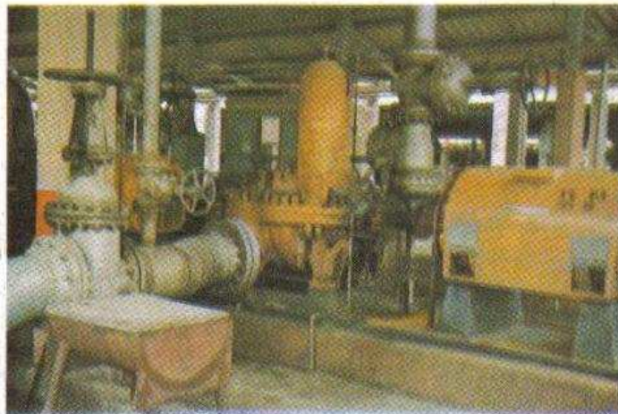
Figura 228. Bomba centrífuga Byron Jackson 12-12-14-2SM. Maneja petróleo crudo de gravedad específica 0.875. Carcaza bipartida horizontal. Es de dos pasos. Gasto = 75.000 barriles/día. Carga = 2.600. Velocidad = 3.500 rpm. Temperatura = 300 HP. (Cortesía Petróleos Mexicanos.)
